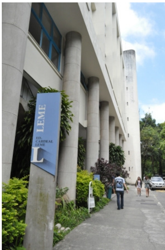
Sinalização do campus que identifica o Edifício Cardeal Leme. Fotografia Antônio Albuquerque. Acervo do Núcleo de Memória da PUC-Rio. 2012.
